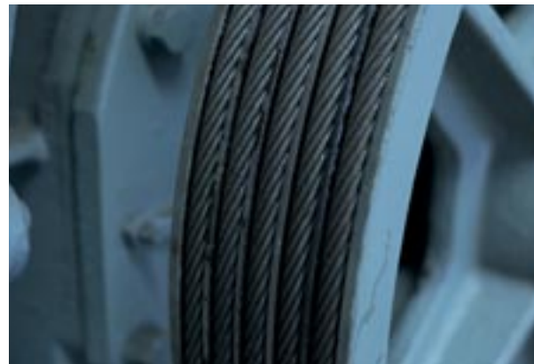
Câbles de traction, ascenseurs, monte-charges, sas, écluses
